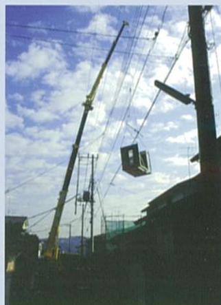
ユニット化された部材を電線越しにつり上げる
