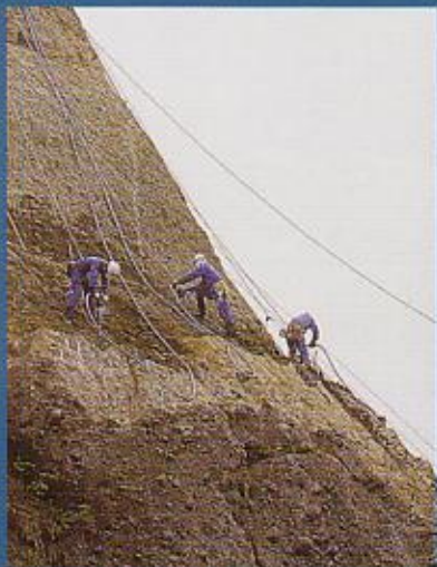
人力による岩盤削工
