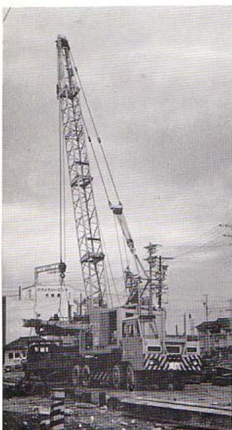
上：建設現場における HC-78 A
