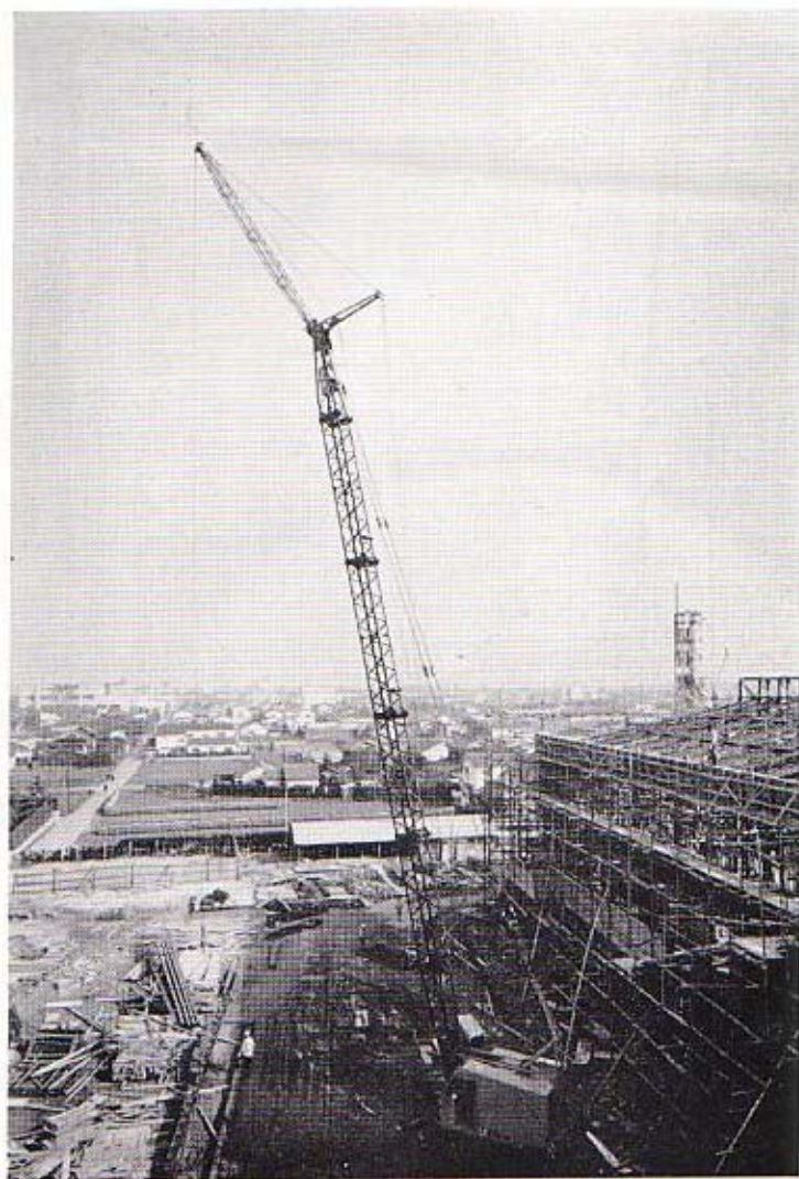
右：体育館建築工事に活躍する HC-78 A
