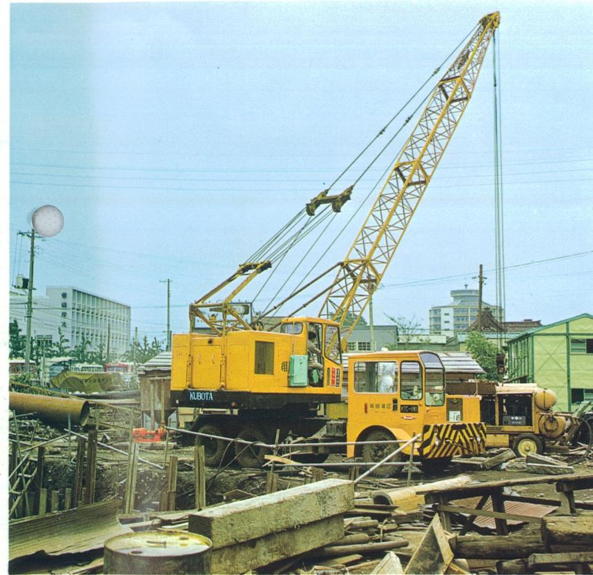
プレハブ住宅の建設に働くKTC-180
