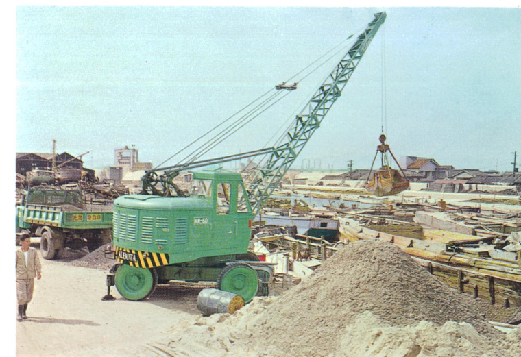
グラブバケットによる土砂運搬作業中のKM60
