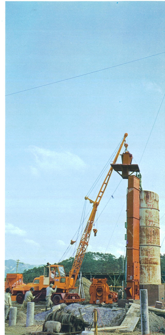
現場組立作業でのKTC-40
