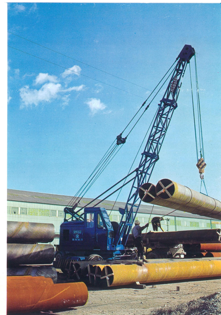
鉄管の出荷作業に働くKM100
