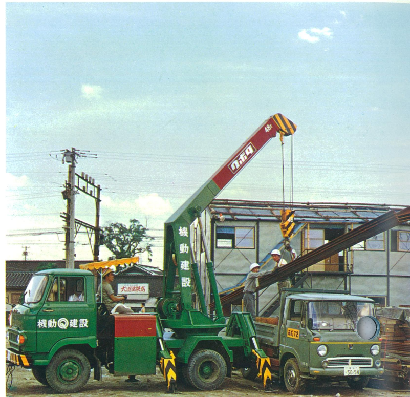
↑ 土木工事現場のKTC-36トラッククレーン
