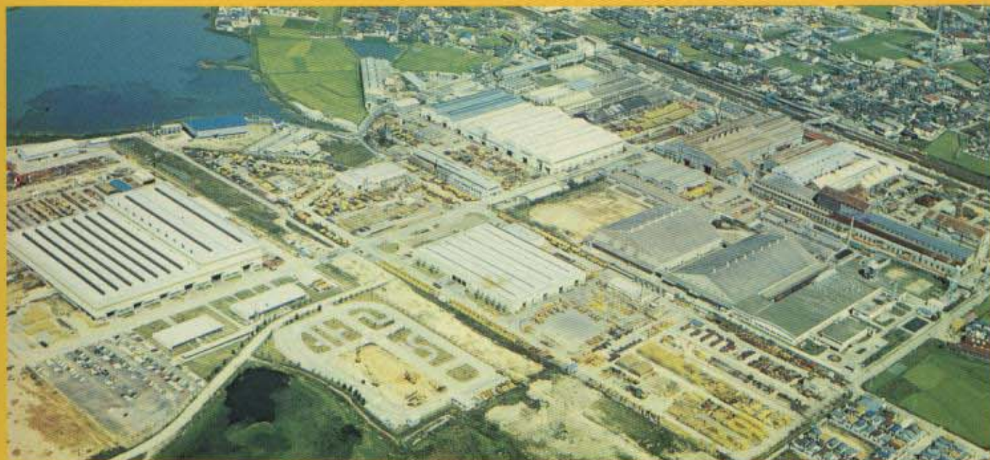
建設機械工場(兵庫県明石市大久保町福田123)
