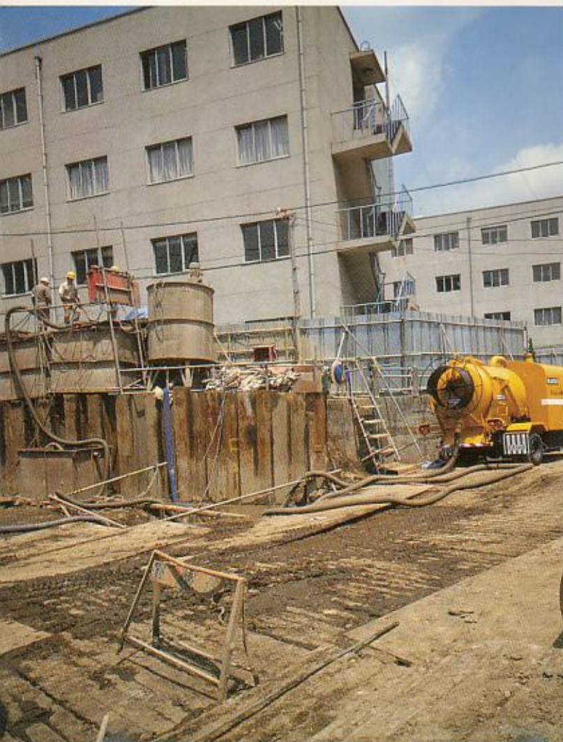
※基礎工事現場のベントナイト溶液の吸引作業
