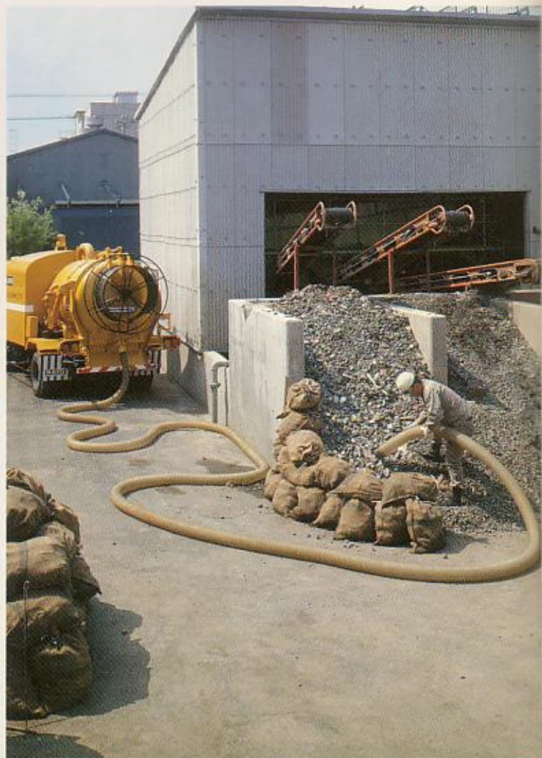
※下水処理場の沈澱槽の吸引清掃作業
